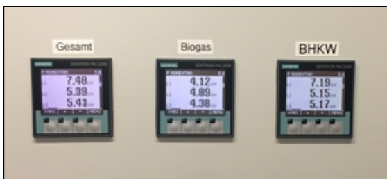
Bild 3: Am Schaltschrank, der gleichzeitig den Übergang zum Stromnetz darstellt, ist jederzeit ablesbar, wie viel die Anlage verbraucht und ob bzw. wie viel Strom vom öffentlichen Netz abgenommen wird
